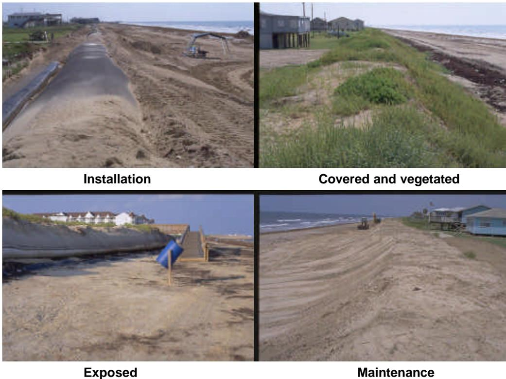
**Figure 2. Geotube stages.**
